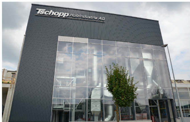
Das neue Altholz-Heizkraftwerk bei Tschopp
